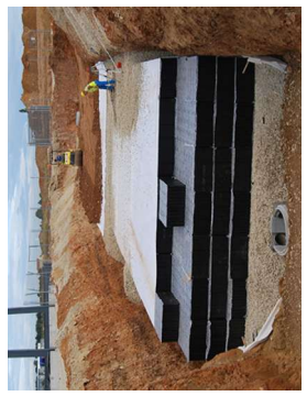
Exemple éléments de rétention
